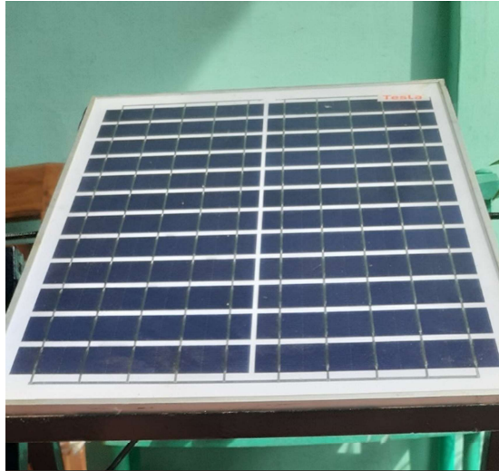
Gambar 3. Perancangan dan Pemasangan Panel Surya
