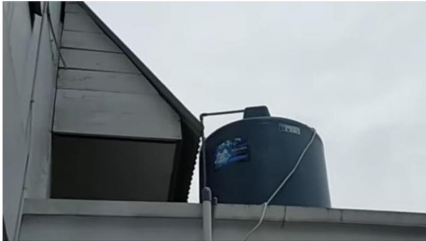
Gambar 6. Tandon (Tangki Penampungan Air) yang berkapasitas 1050 L
